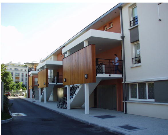
Construction de logement sociaux à Versailles
