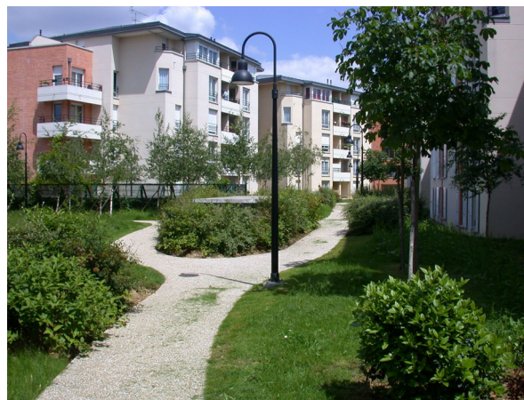
Construction de logement sociaux au Chesnay
