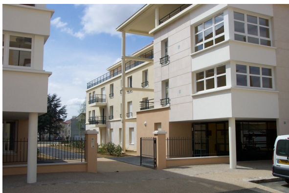
Construction de logement sociaux à Guyancourt
